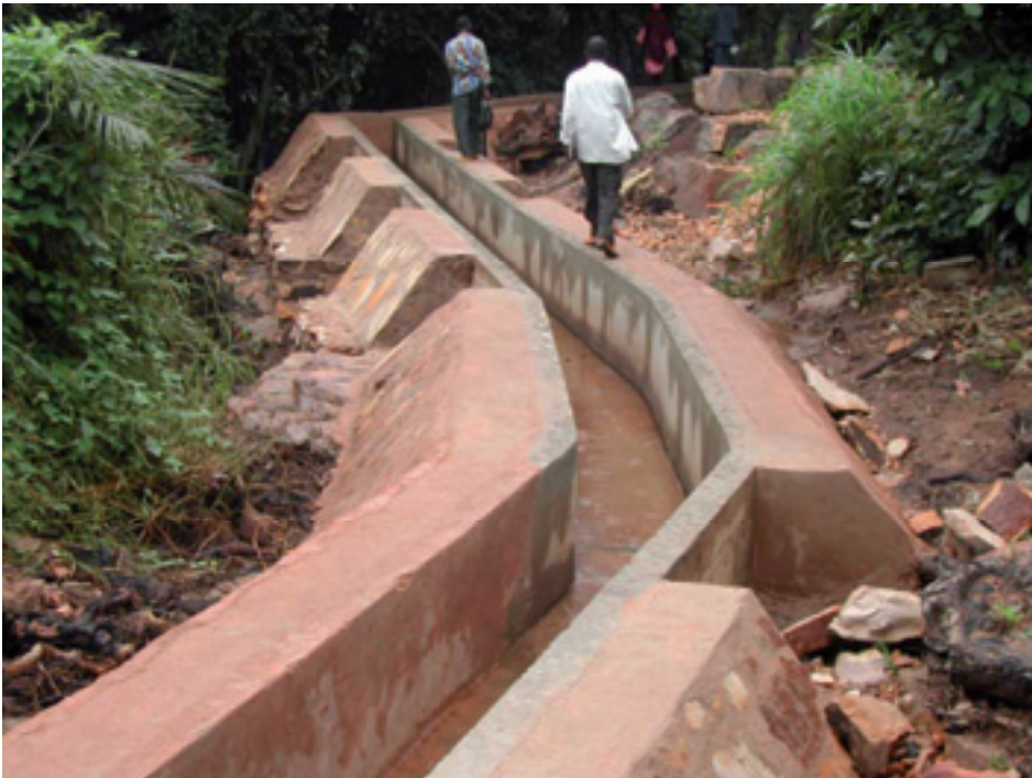
Sirakorobougou (Mali): Canal
